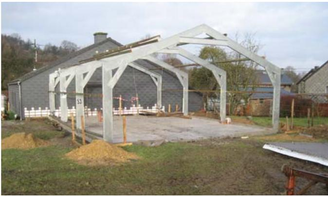
La dalle de béton est coulée et la superstructure du hangar est déjà remontée à la bonne place
